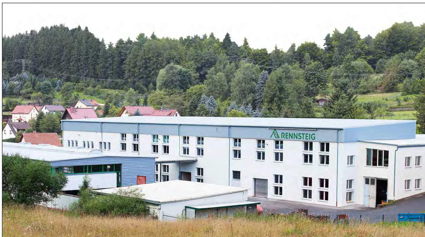
Betriebsteil Altersbach Manufacturing site Altersbach
